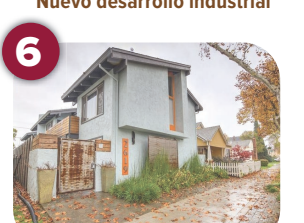
6 Viviendas en terrenos baldíos
